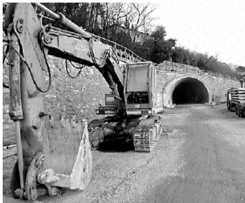
L'ingresso della galleria all'altezza di Crema: lo sbocco è a poche decine di metri dal lungolago di Dongo
